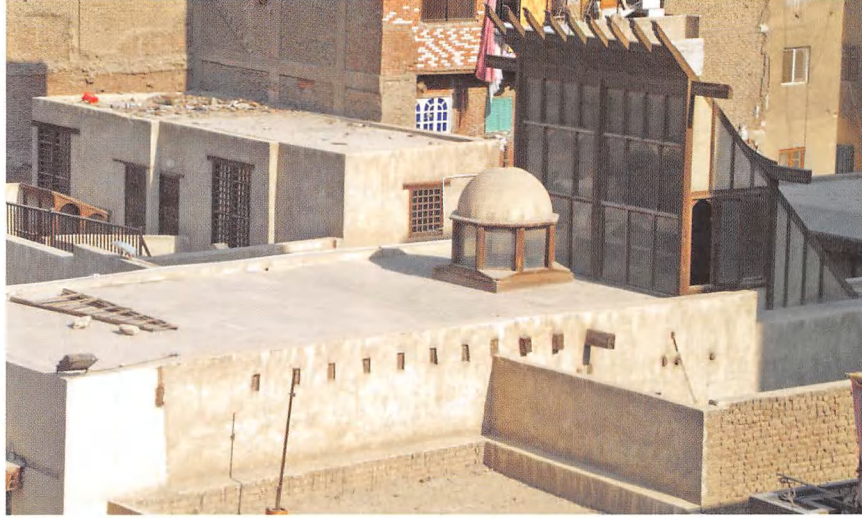
(لوحة 89) سقف البيت ويظهر بها الملقف الكبير والقبة لتهوية القاعة الكبرى، ويسار الصور الملقف الخشبي الصغير بتهوية غرف وأماكن قسم الحرم.
